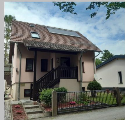
10 m 2 Solarthermie Kollektoranlage
