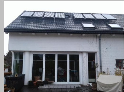
Danach: 2m 2 Wärmehamster© und 17m 2 Solaranlage made in Saxony
