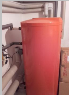
Vor dem Umbau: Warmwasser Boiler 200L und Süddach über dem Pool
